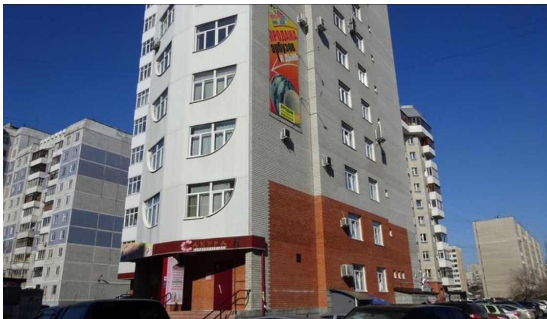
Общий вид здания в котором расположен объект оценки
